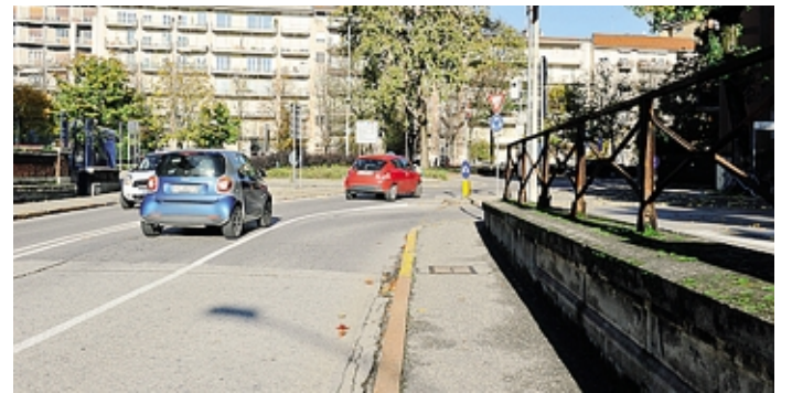
Iniziano lunedì i lavori per la ciclabile nel sottopasso di via San Colombano
